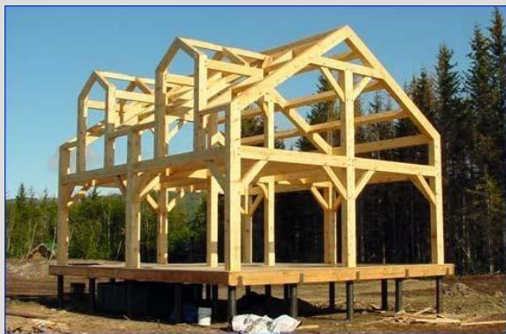
Grinzi din lemn cu rol structural într-o construcție din lemn
